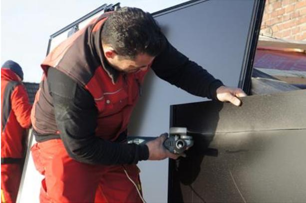
Fig. 10: Découpe du module factice sur le chantier
