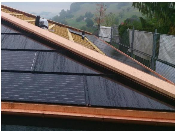
Fig. 1: Raccordement avec un arêtier d'un toit en croupe
