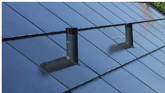
Fig. 6: Deux modules factices ayant chacun un orifice pour le passage d'un conduit de ventilation
