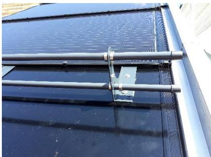
Fig. 5: Zone d'écoulement avec dispositif de retenue de la neige ancré sur des modules factices
